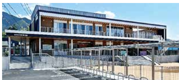
私立保育所等施設整備事業 2億5,298万円 認定こども園施設整備事業 1億3,566万円 中萩保育園の新築整備事業および愛光幼稚園の新築整備事業に補助を行いました。
