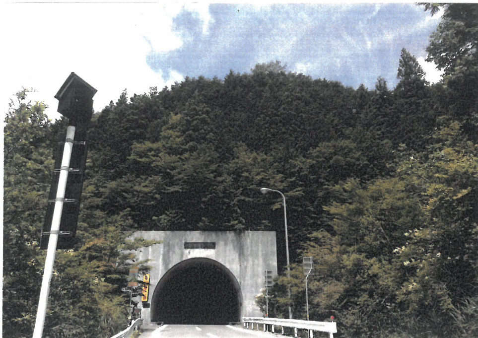
大永山トンネル(別子山側より)
