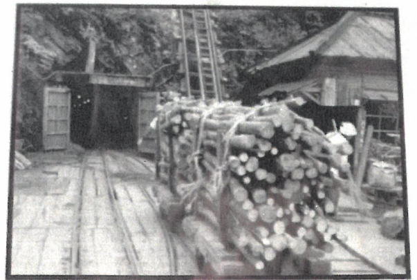
ひうらつうどう 日浦通洞 (標高 765m) Hiura Adit
