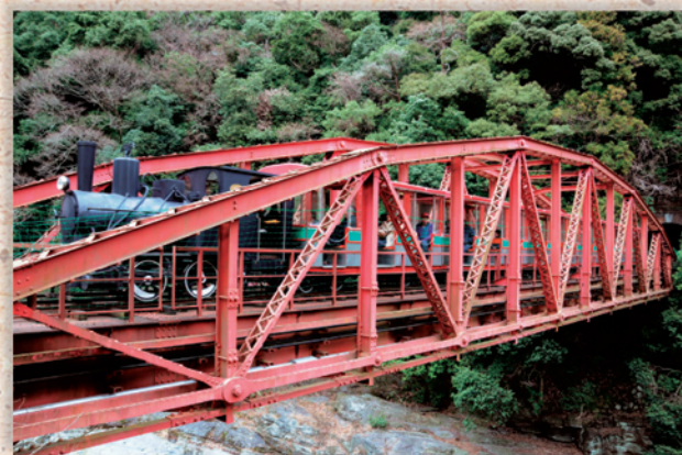
●端出場鉄橋・端出場隧道 (国の登録有形文化財) 明治26年、別子鉱山鉄道下部線の一部として建設される。橋はドイツのハーコート社が製作。
