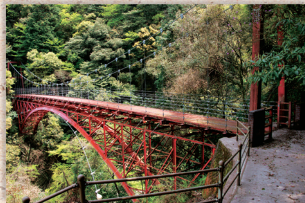
●遠登志橋 (国の登録有形文化財) 明治38年建設。現存する鋼アーチ橋としては、国内最古級。平成5年にアーチ部分を残り、新たに吊り橋を架設。
