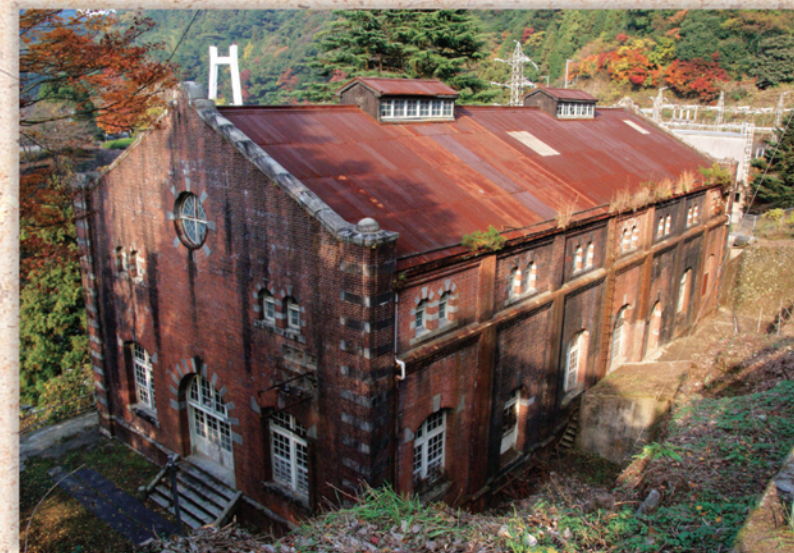
●旧端出場水力発電所 (国の登録有形文化財) 明治45年、本格的な電力供給施設として建設される。操業時の出力は、最大3000キロワット。597メートルの落差を利用して発電した。
