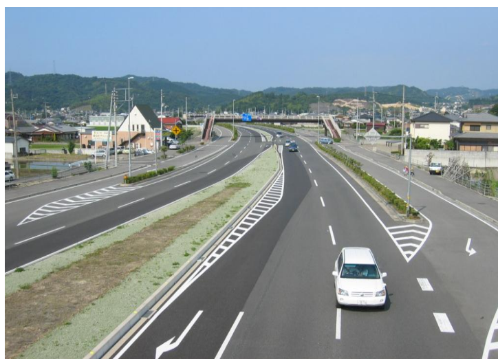
国道 11 号新居浜バイパス（星原町）
