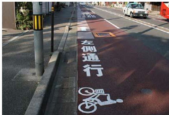
車道の幅員構成を見直し、自転車走行空間を確保した事例
